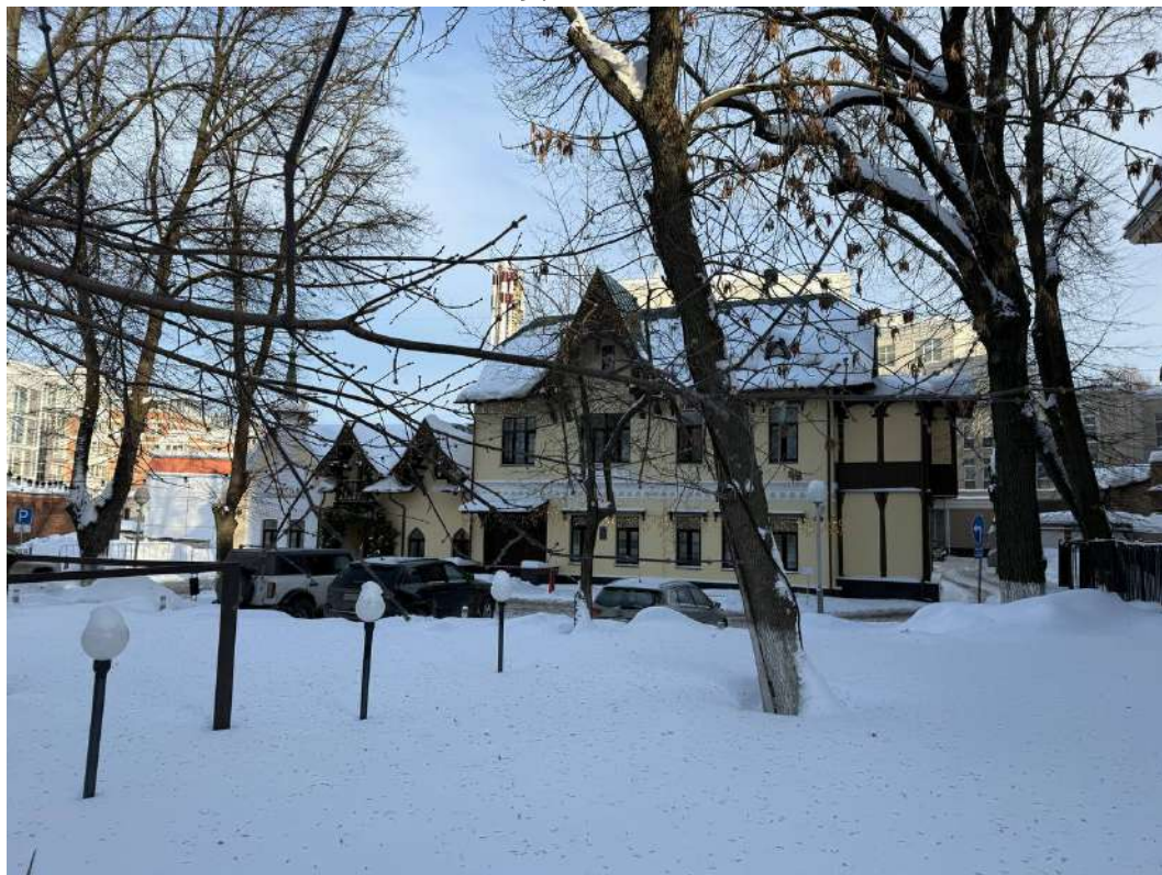
Фото 36. Объект культурного наследия регионального значения «Дом Д.В. Сироткина» (Нижегородская область, г. Нижний Новгород, ул. Ильинская, 46 (литеры А, А1, А2)).
