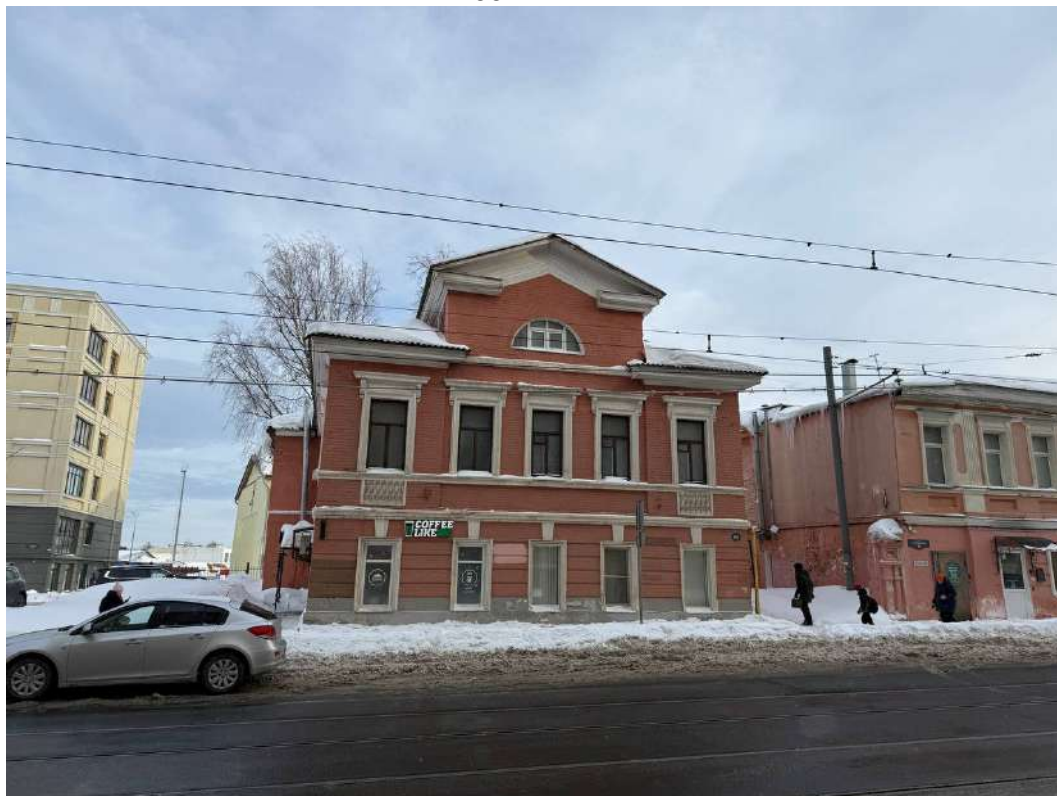
Фото 17. Объект культурного наследия регионального значения «Дом А.П.Пуговкина» (Нижегородская область, г. Нижний Новгород, ул. Ильинская, 68 (литеры А, А1)).
