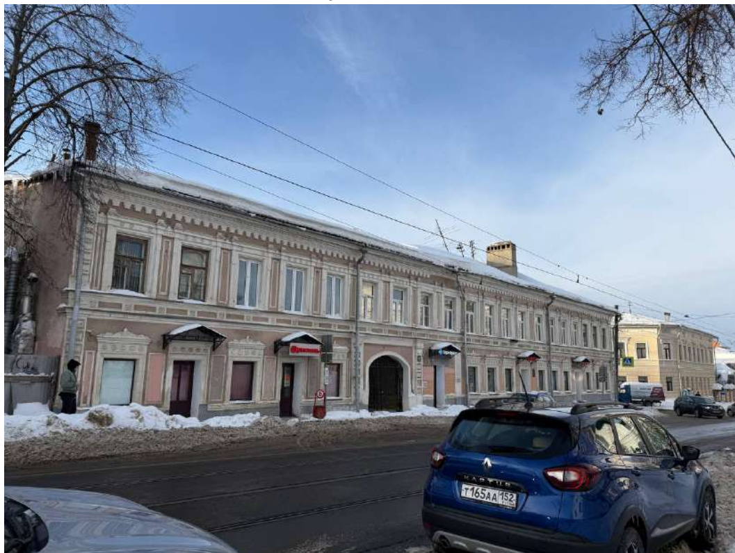
Фото 30. Объект культурного наследия регионального значения «Жилой дом» (Нижегородская область, г. Нижний Новгород, ул. Ильинская, 53/2 (литеры А, А1)).
