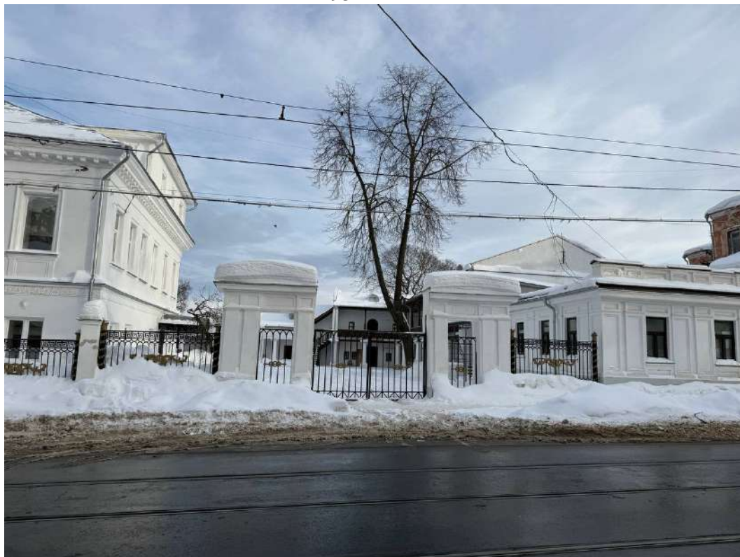
Фото 28. Объект культурного наследия федерального значения «Усадьба Рябиной» (Нижегородская область, город Нижний Новгород, улица Ильинская, дом 56). Ограда усадьбы Рябиной».
