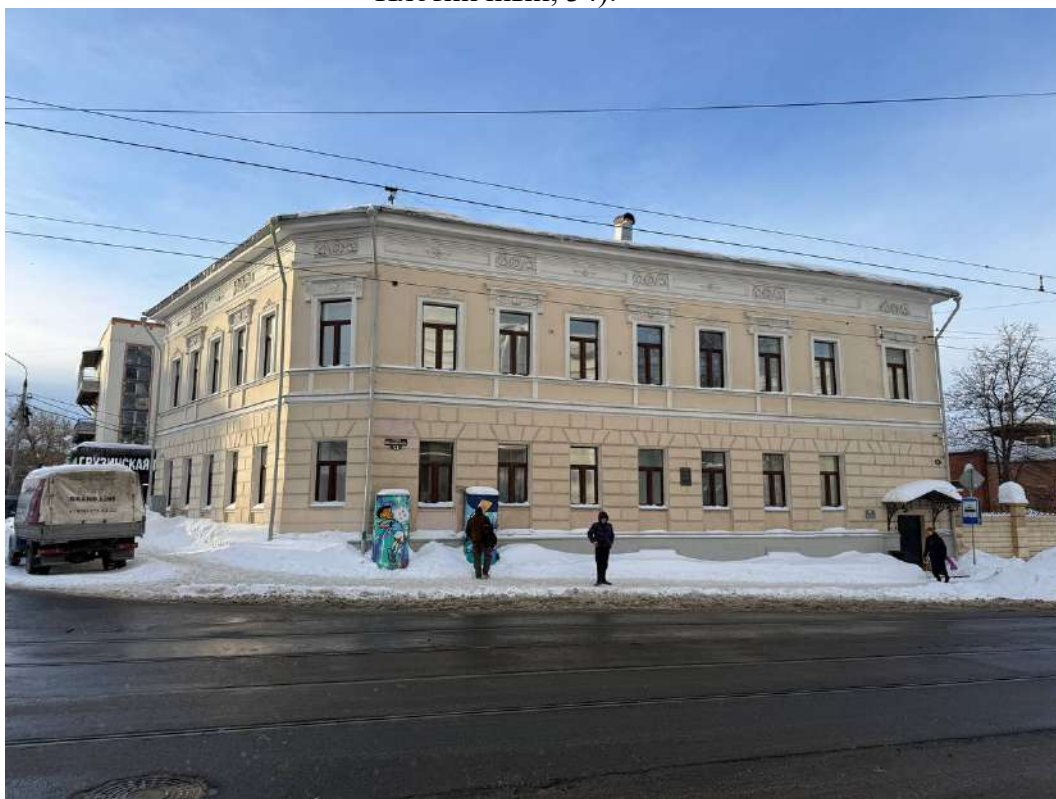
Фото 33. Объект культурного наследия регионального значения «Жилой дом» (Нижегородская область, г. Нижний Новгород, ул. Ильинская, 51/1 (литеры А, А1)).
